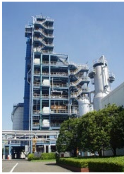
川崎プラスチックリサイクルプラント(KPR)
