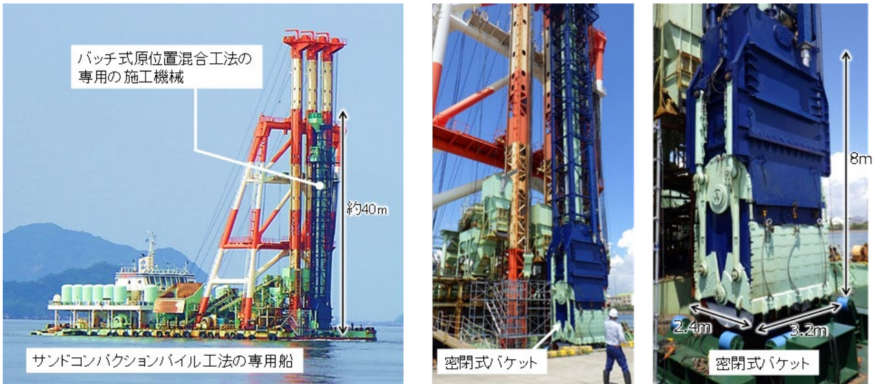
【図4】バッチ式原位置混合工法の施工船
