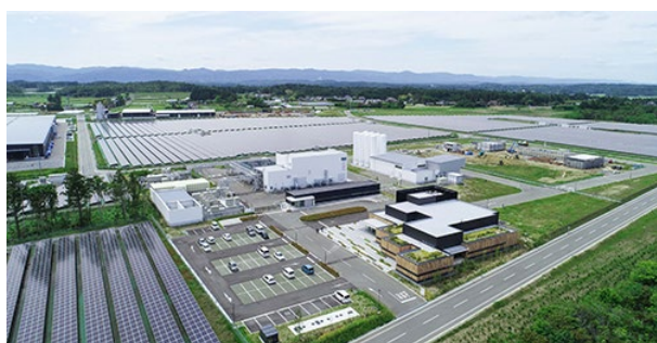
福島水素エネルギー研究フィールド (FH2R) 提供: NEDO
